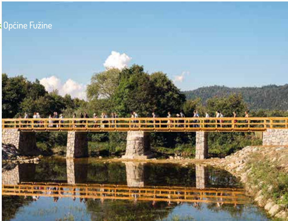
Obnovljen povijesni Vicićev most u Liču
